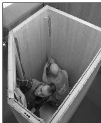
Рисунок 4. Последний стык в углу помещения
