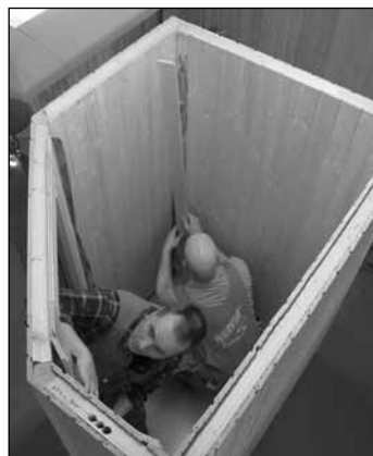
Schéma 4. Dernier joint dans le coin de la pièce Afbelding 4. Laatste verbinding in hoek van de ruimte
